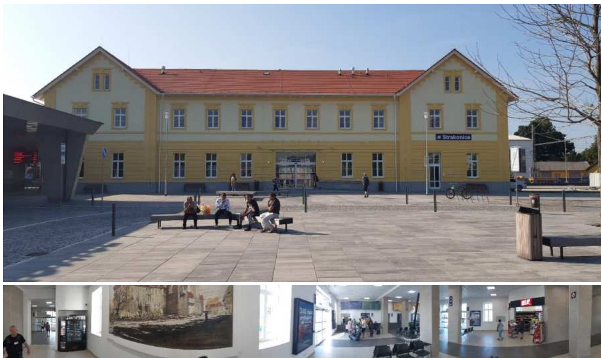
Obrázek 67 – přestupní terminál ve Strakonících, který umožňuje komfortní přestup autobus – vlak. Celé území prošlo zásadní proměnou v letech 2020 – 2021 výstavbou přestupního terminálu u ŽST Strakonice, vybudování P+R, K+R a B+R a rekonstrukcí výpravní budovy, která poskytuje dostatek pohodlí při čekání. V sousedství se rovněž nachází středně velký obchod s potravinami
